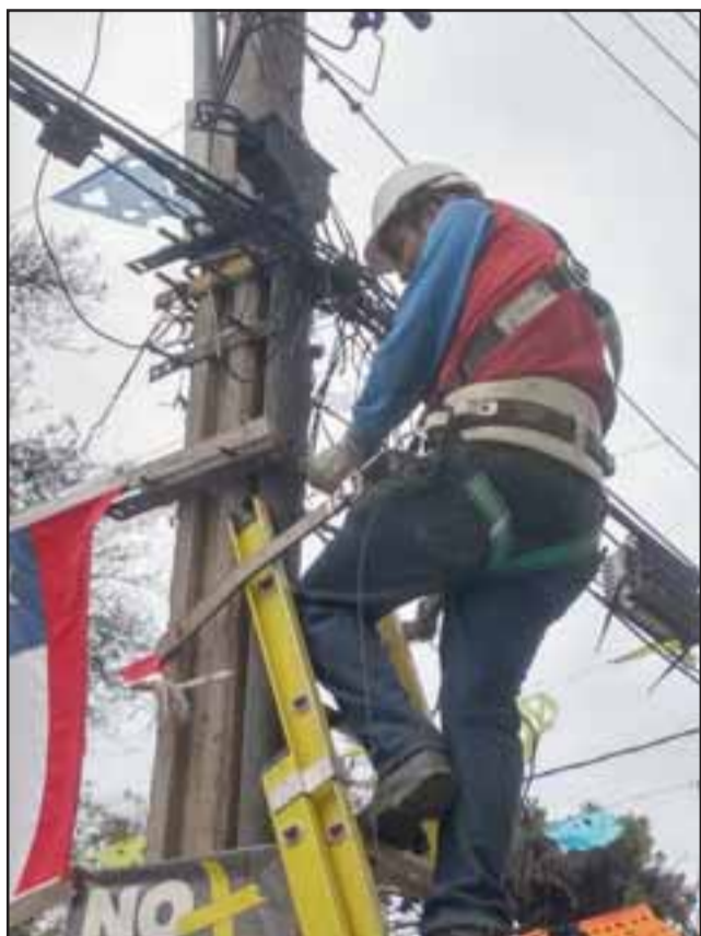
Una de las empresas de telefonía que ya comenzó con esta nueva etapa de ‘amarre y enlace’ de cables en desuso en San Felipe, los que seguirán ocupando el espacio aéreo.
