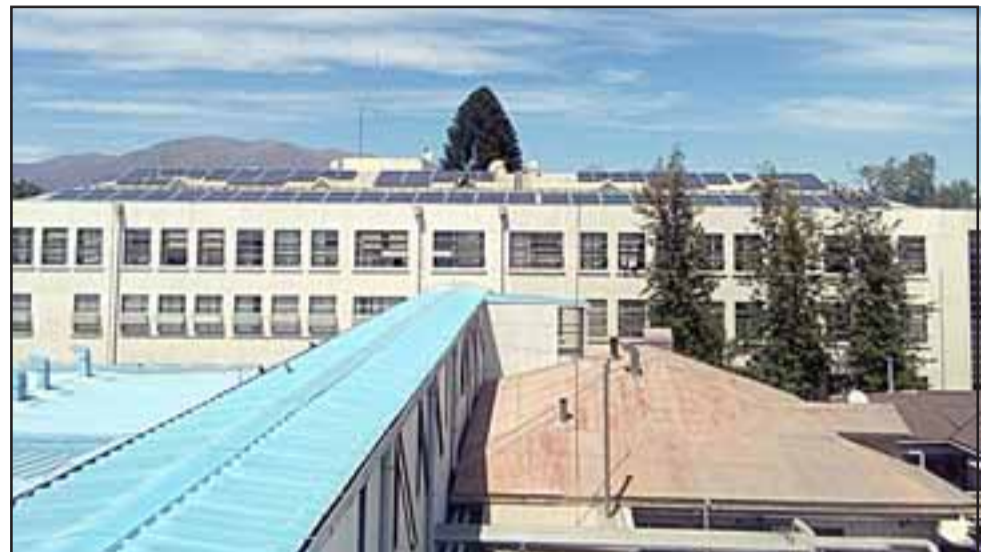
Los paneles del Hospital San Juan de Dios de Los Andes requirieron una inversión de $33.000.000, tienen una capacidad de 25 kW, lo que corresponde a un 3% de su autoconsumo, lo que les permitirá ahorrar hasta 13 millones y medio de pesos al año que podrán ser destinados a otros ítems del recinto.
