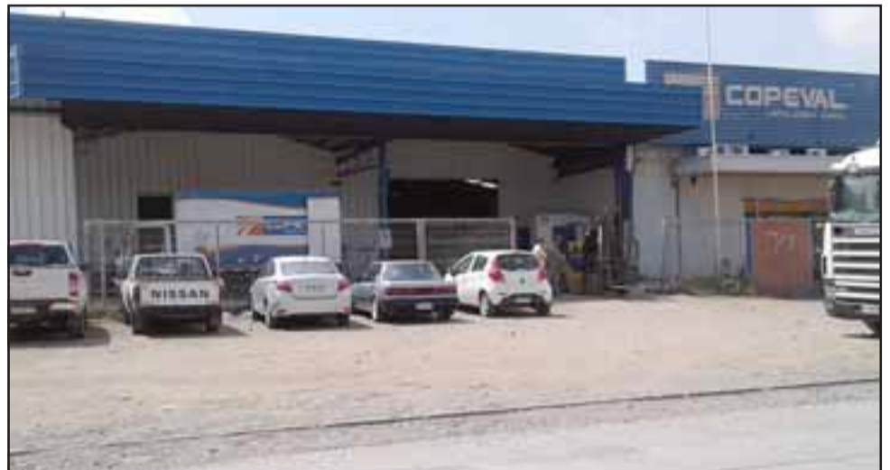
Al interior de esta empresa se producía la activación de las alarmas que molestaban y no dejaban dormir a los vecinos.
