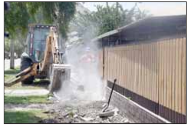
Los trabajos demandaron una inversión de 40 millones de pesos financiados a través del Fondo Regional de Inversión Local (FRIL).
