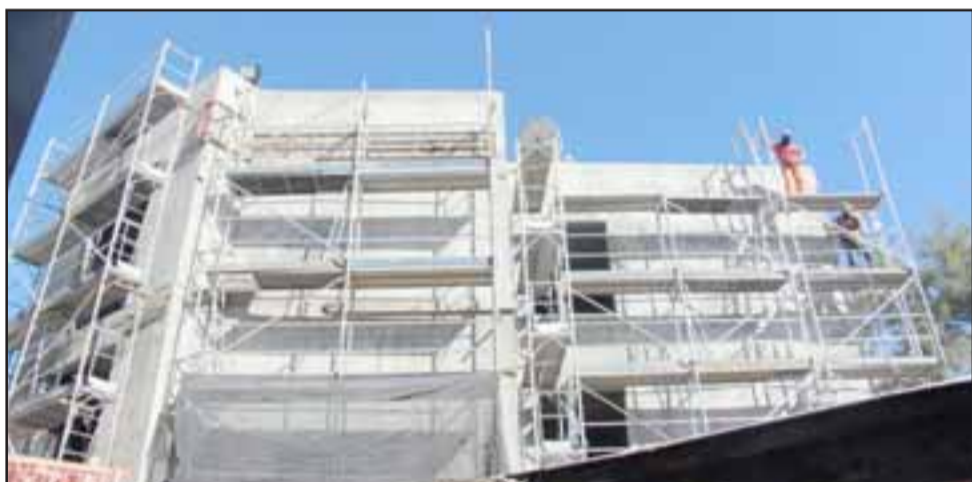
La normalización del Hospital Psiquiátrico Dr. Philippe Pinel de Putaendo, contempla el reforzamiento estructural completo de las cuatro alas del edificio para mejorar su resistencia sísmica.
