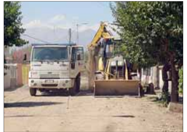
El Serviu pavimentará 1.215 metros lineales en la provincia de Los Andes.
