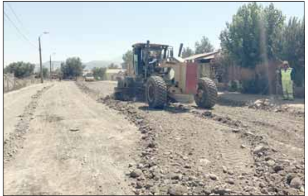
La carpeta asfáltica de 7 centímetros permitirá el tráfico de vehículos livianos, poniendo fin a más de 20 años de polvo, barro y cráteres que hacían intransitable el tramo de 151 metros que conecta Diego de Almagro Tacna Norte.
