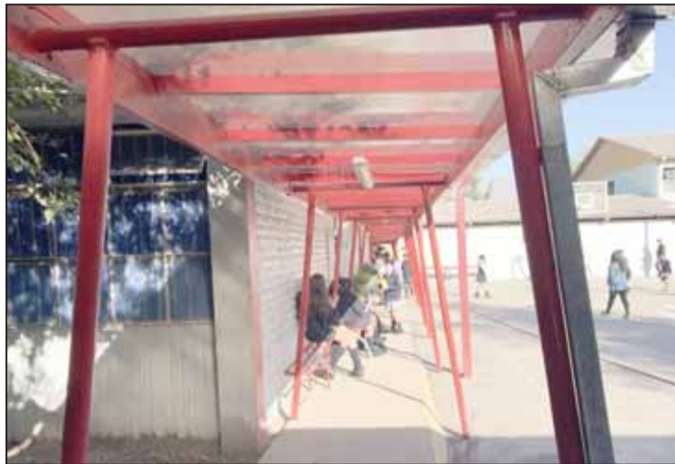
Utilizando el Fondo de Apoyo a la Educación Pública se mejoró el techo del pasillo que conecta varias dependencias de la escuela, con el objetivo de recibir en las mejores condiciones a los alumnos.
