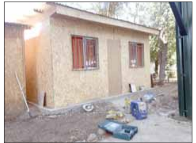
El nuevo techo está prácticamente terminado por lo que este lunes 12 se inician las clases en la escuela José Bernardo Suárez de El Asiento.
