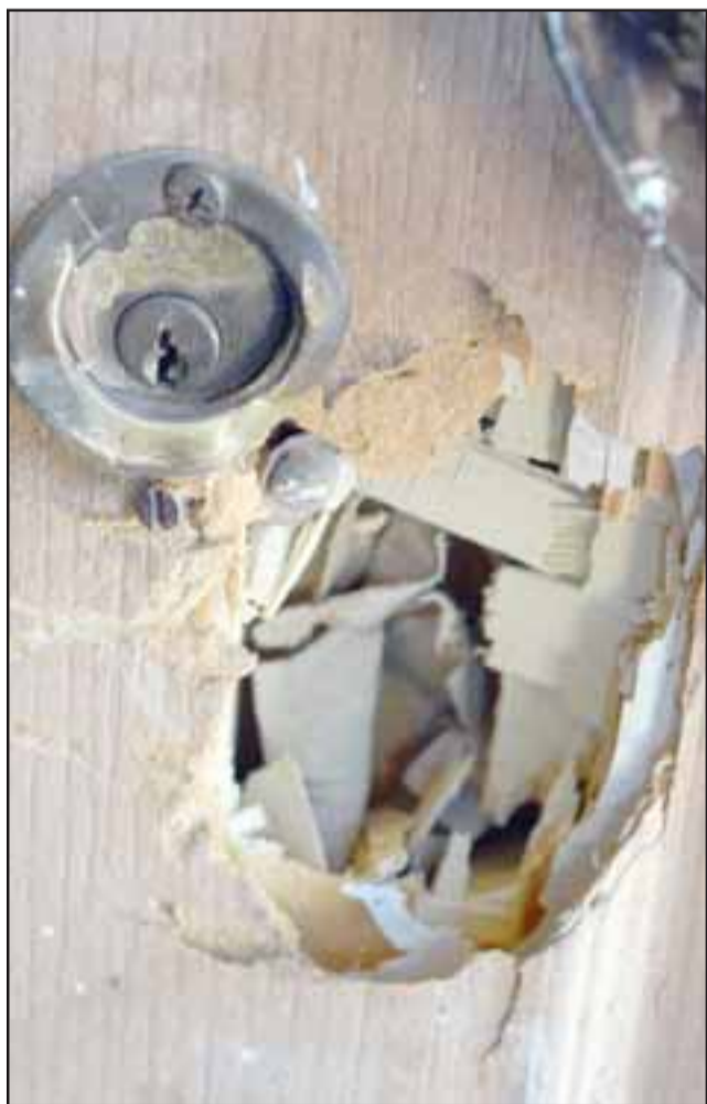
PUERTA DAÑADA.- La puerta de la casa de Rosendo quedó seriamente dañada, al final no pudieron lincharlo, pero poco faltó.
