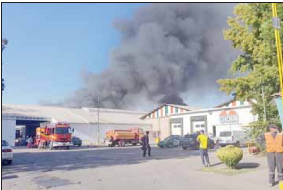
Una inmensa columna de humo visible desde distintas partes de San Felipe originó el siniestro que afectó a la planta.
