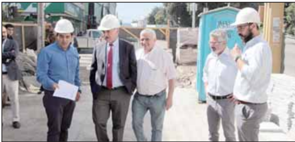
El alcalde Patricio Freire, junto a concejales y directores de departamentos municipales, realizaron una revisión en terreno de las obras del nuevo boulevard (que presenta un avance del 85%) donde hicieron un llamado a la 'comprensión de los vecinos, porque son obras para una ciudad de futuro'.
