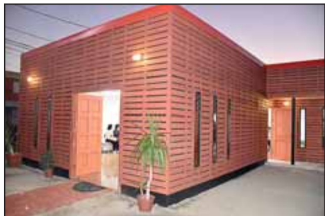
La nueva sede comunitaria abarca un total de 84.15 m 2 de superficie, que contempla el mejoramiento estructural de su salón principal y la ampliación de su cocina.
