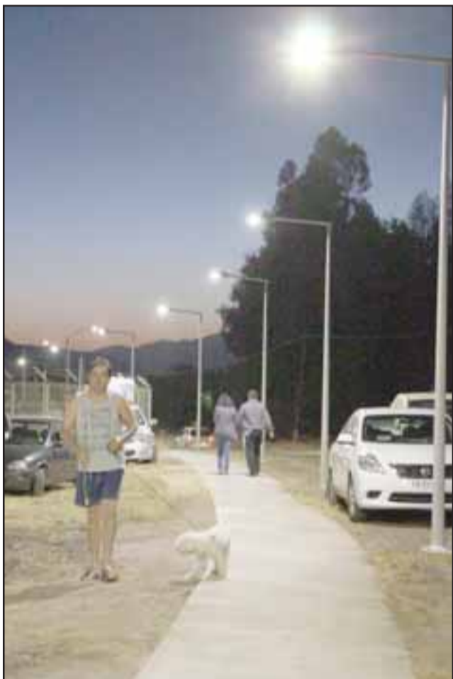
El cordón de iluminación compuesto por 14 luminarias peatonales con tecnología Led, viene a entregar mayor seguridad para el tránsito peatonal y vehicular en este sector.
