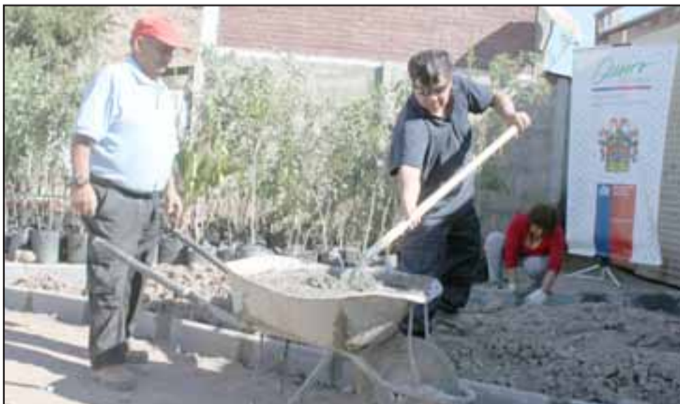
SUMANDO IDEAS.- Vecinos y empleados municipales ejecutaron el trabajo pesado en esta nueva plazoleta de Las 4 Villas.
