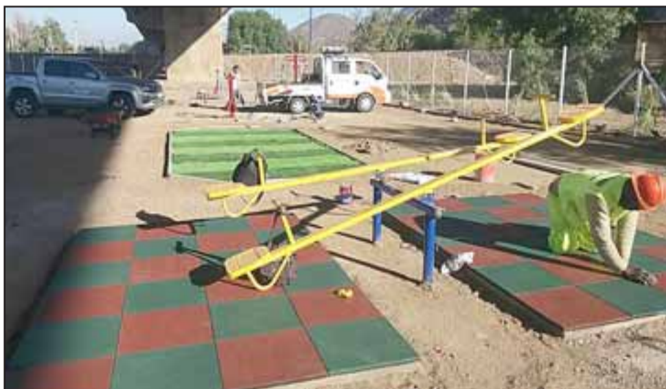
Los empleados de Autopistas Los Andes emplearon muchas horas y recursos para instalar este complejo recreativo con sus juegos y cierre perimetral.
