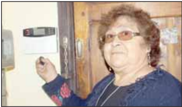
HOGARES SEGUROS. - Doña Carmen Madrid muestra a Diario El Trabajo la alarma ya instalada en su casa.
