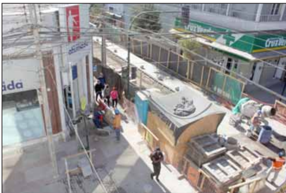
ESVAL TRABAJANDO.- Así luce actualmente el tramo Salinas entre Prat y Santo Domingo, el que pronto también estará listo para su uso público.
