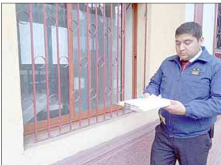
Delincuentes cortaron la alarma e ingresaron rompiendo los barrotes de una ventana del frontis del inmueble ubicado en calle O'Higgins.
