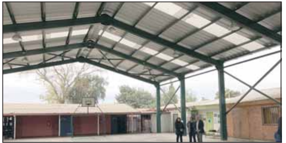
El nuevo techo es una estructura metálica con iluminación Led, mismo diseño que se replicará en las escuelas Carolina Ocampo del sector de Bellavista, John Kennedy y en Bucalemu.
