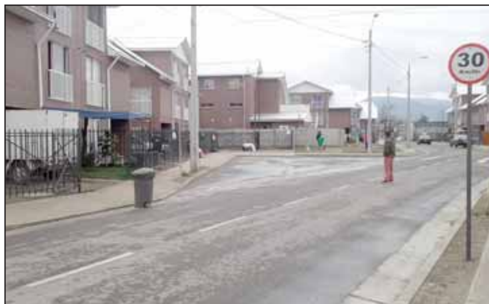
Entrada del Condominio Peumayén de San Felipe donde están los problemas denunciados ayer en Diario El Trabajo.
