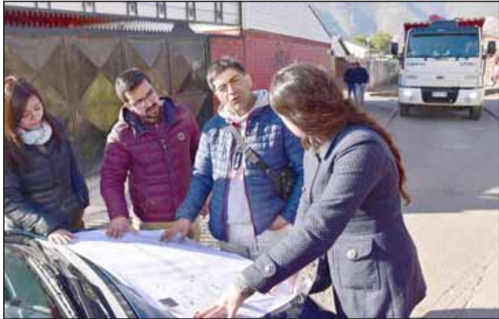
El alcalde Edgardo González Arancibia y la Directora de Obras Municipales, Daniela Vargas , realizaron una inspección en terreno de los trabajos de repavimentación de pasajes en Villa Padre Hurtado.
