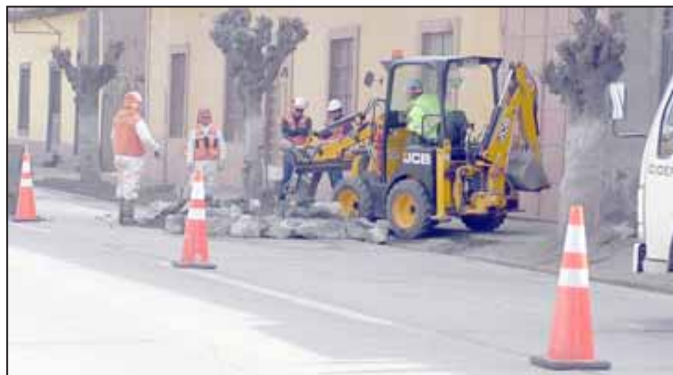
A partir de este mes de agosto se retoman los trabajos de construcción de redes de alcantarillado en Curimón.
