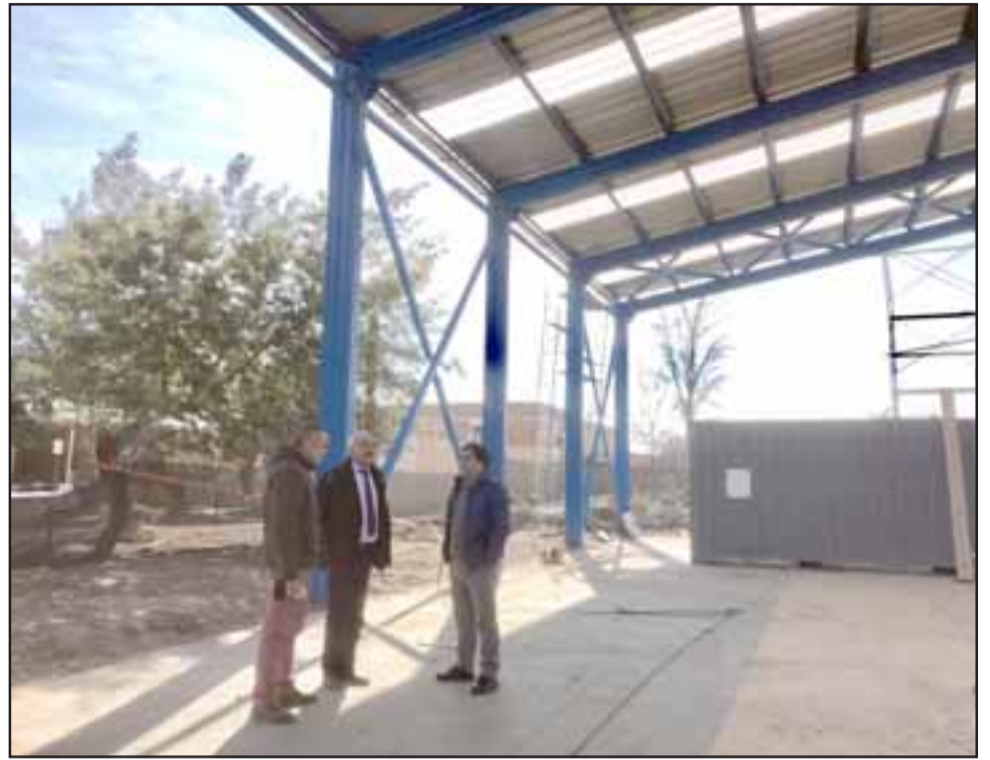
Más de cien alumnos de la Escuela Carolina Ocampo, del sector de Bellavista, ya cuentan con el patio principal del establecimiento completamente techado.
