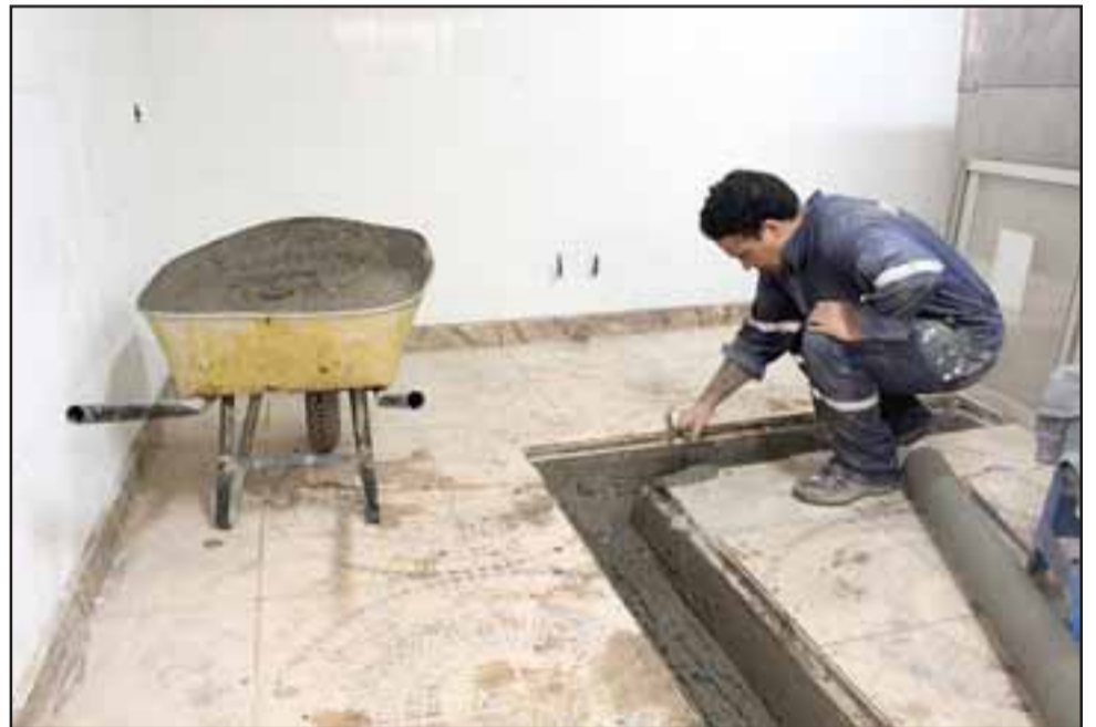
Las obras de mejoramiento fueron posibles gracias a los fondos concursables que entrega el departamento de Bienestar.
