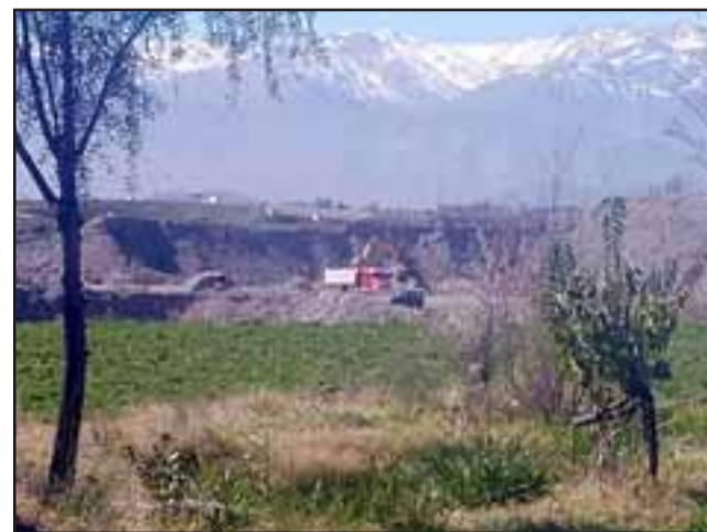
Maquinas trabajando al interior de la planta tres esquinas que estaba clausurada.
