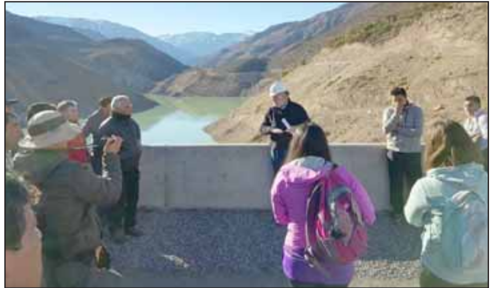
Los visitantes fueron recibidos por el inspector fiscal, David Acuña, quien los guió por el lugar y brindó una charla donde detalló el funcionamiento del embalse.
