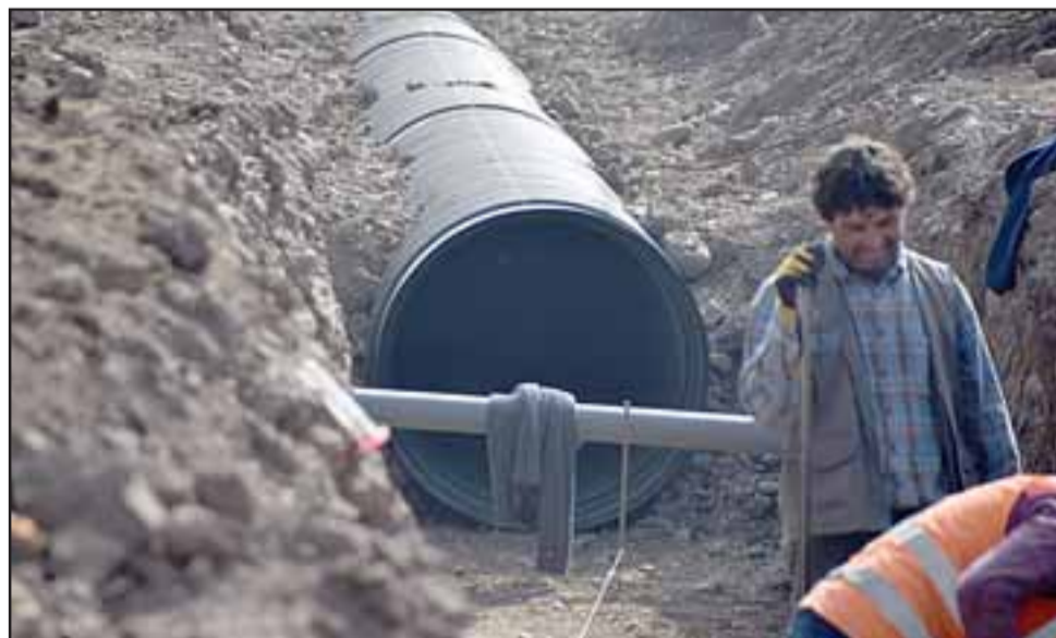
ALCANTARILLADO NUEVO. - Esta arteria, Abraham Ahumada, cuenta con un nuevo ducto para aguas lluvias y aguas servidas del sector.
