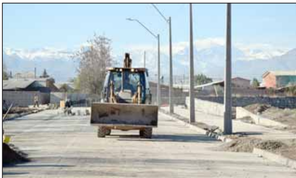
LISTA PARA INAUGURAR. - Calle San Martín ya fue terminada, la maquinaria fue retirada de esa vía hace una semana.
