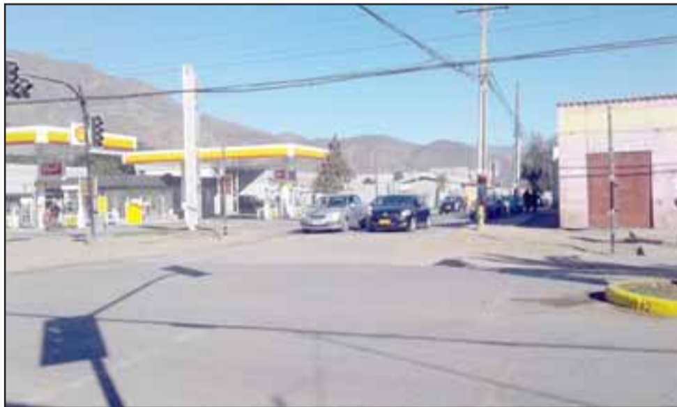
En Chorrillos con Maipú el estado de la calzada es tan malo que en las mañanas se generan tacos interminables, debiendo sumar un semáforo tan corto que prácticamente alcanza a pasar uno o dos vehículos, no más, en cada ciclo en verde para los que salen de Chorrillos.
