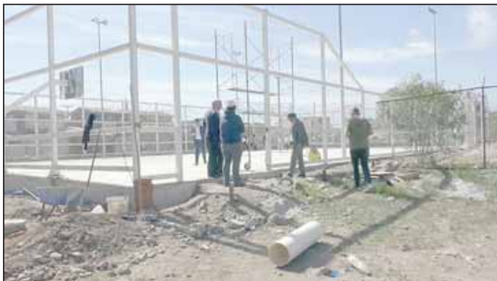
Un avance del 70 por ciento presenta la multicancha que se construye para Las Cuatro Villas, un sector postergado que ahora verá cristalizada una antigua aspiración.
