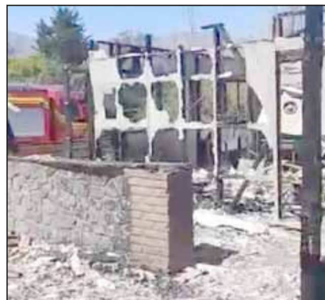
El incendio dejó serios daños y desde un comienzo se barajó la tesis de la intencionalidad debido a la evidencia encontrada en el lugar.
