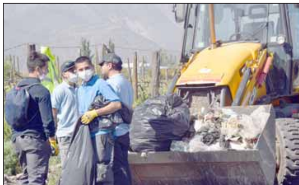
MUCHA BASURA.- Maquinaria especial fue empleada para lograr el acopio de material pesado y peligroso hacia los camiones.
