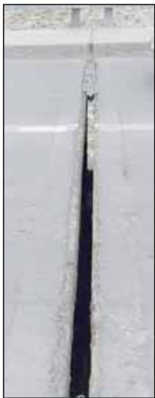
En la imagen se aprecia el orificio que quedó al descubierto luego que la huincha de caucho se cayera. (Foto Cristian Labra).
