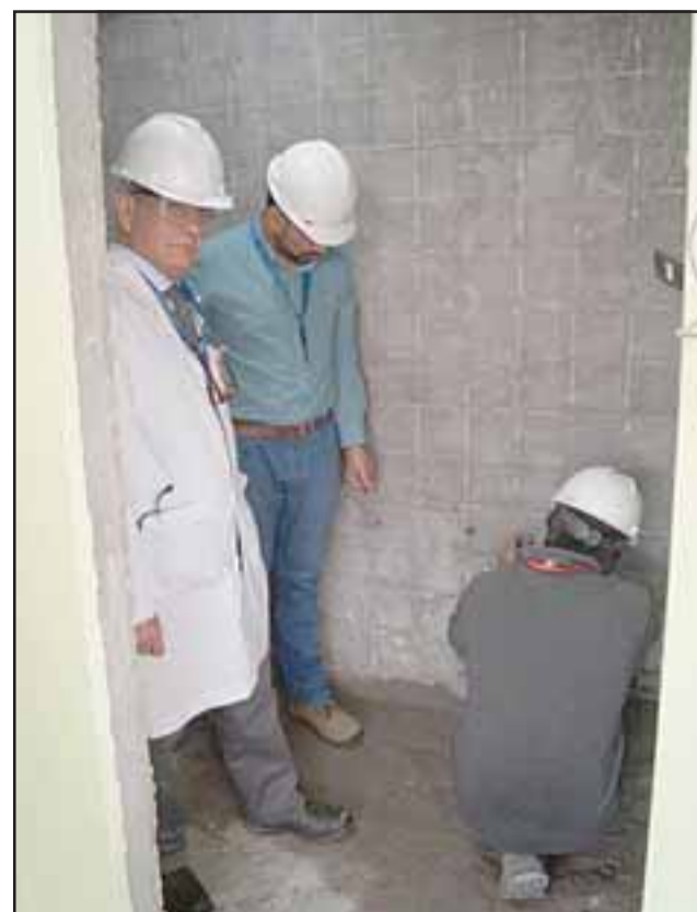
La remodelación afecta básicamente los baños de usuarios que se utilizan en los servicios clínicos de Medicina, Cirugía, Pediatría, Maternidad y Pensionado.
