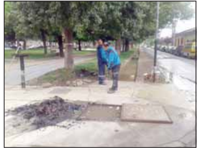
Personal de la municipalidad de San Felipe trabajando arduamente para despejar el canal.
