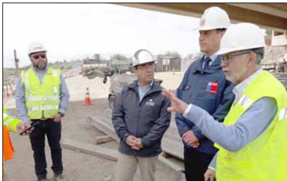
El Seremi de OOPP Rodrigo Sepúlveda acompañado del gobernador Claudio Rodríguez junto a representantes de la empresa, en una visita inspectiva a los trabajos.
