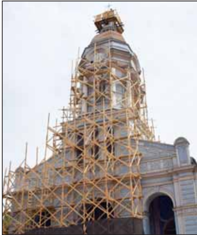
EN REPARACIONES.- Así luce actualmente la parroquia San Antonio de Padua, pero muy pronto su aspecto será otro.
