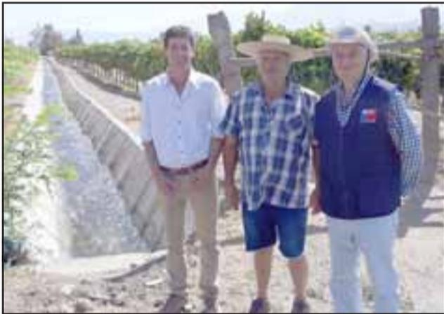
El canal fue revestido en 1.291 metros con losetas de hormigón que evitan la infiltración del agua y que llegue más rápidamente a los predios de los agricultores, beneficiando indirectamente a más de 100 familias campesinas.
