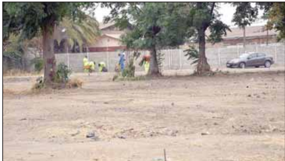
El proyecto de 6.600 m2 de superficie contempla áreas verdes, con un sistema de riego tecnificado, juegos infantiles, instalaciones eléctricas con canalización subterránea, proyectos de paisajismo y especies vegetales.
