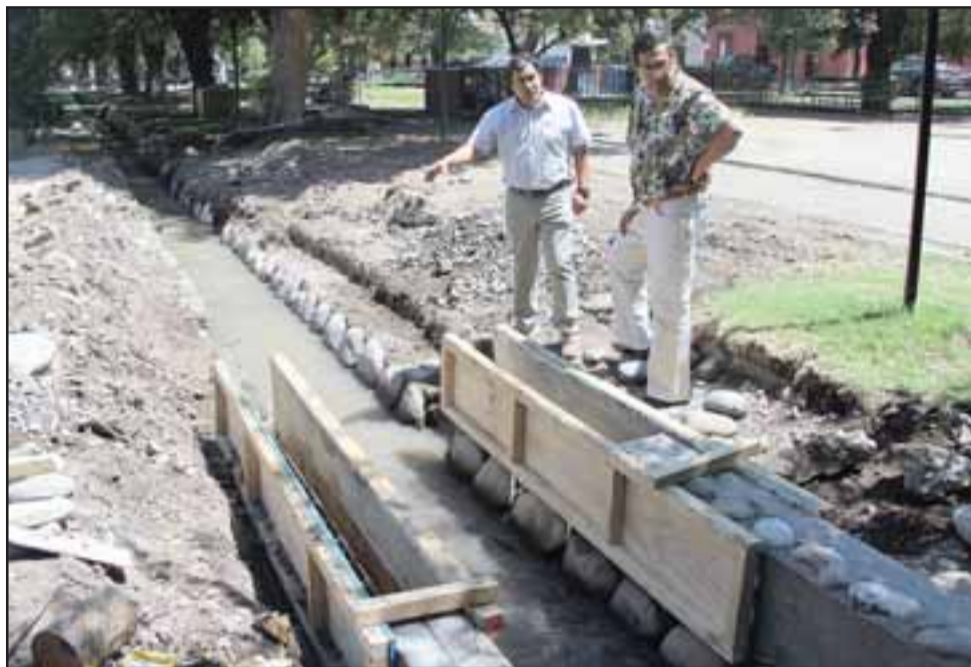
El Secpla Claudio Paredes junto al director de Obras Municipales, Claudio Díaz, inspeccionan el lugar donde se realizan los trabajos.
