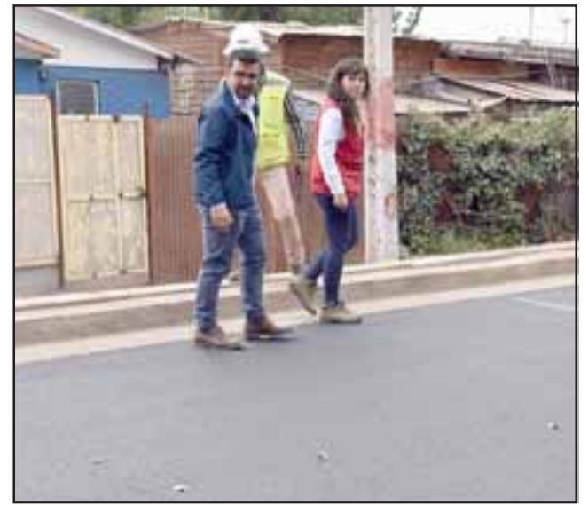
El alcalde Edgardo González junto a la directora de Obras, Daniela Vargas, y personal de la empresa a cargo de las obras, en visita realizada a los trabajos de pavimentación en población Santa Teresa.
