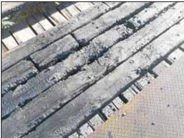
Así quedaron los durmientes del puente, reducidos a cenizas por la acción del fuego.
