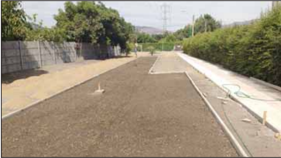
Un 60% de avance registran las obras de construcción de un paseo peatonal en Villa Lo Campo de la comuna de Panquehue.
