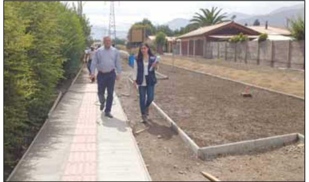
La obra fue inspeccionada por el alcalde Luis Pradenas en compañía de la directora (S) de Obras Municipales, Valery Salinas Maturana.
