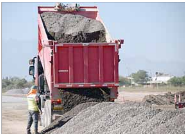
DE MEJOR CALIDAD.- Mucho material de lo que se esperaba se está usando en la obra, luego que la empresa que postuló propusiera ampliarla a 30 metros de ancho.
