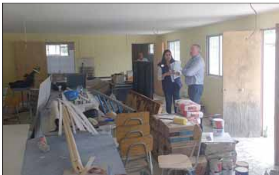
Los trabajos demandan una inversión de 19 millones de pesos y se llevan a cabo por parte de una empresa contratista que se adjudicó el proyecto.
