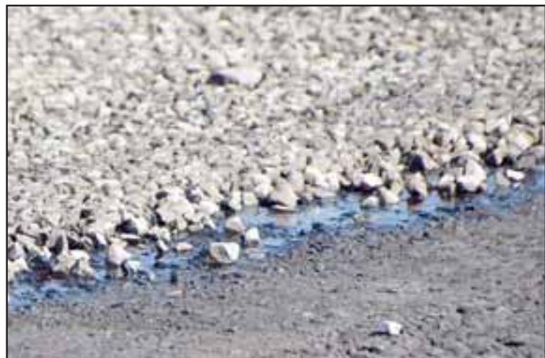
MÁS RESISTENTE.- Este agregado tiene un espesor de 15 centímetros, o sea, esta pista no fue demolida, la reutilizaron y adjuntaron la nueva capa.
