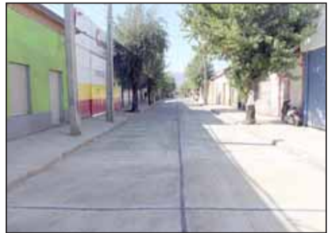
Así lucen las obras actualmente en Abraham Ahumada. El mismo jueves queda habilitada la vía desde Chacabuco hasta Circunvalación Santa Teresa, el proyecto se entregará a principios de abril.
