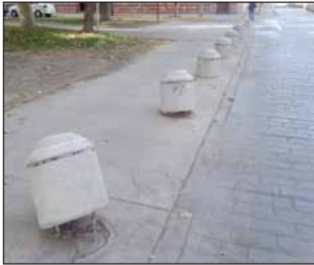
Acá dos bolardos por desprenderse de sus respectivas bases.
