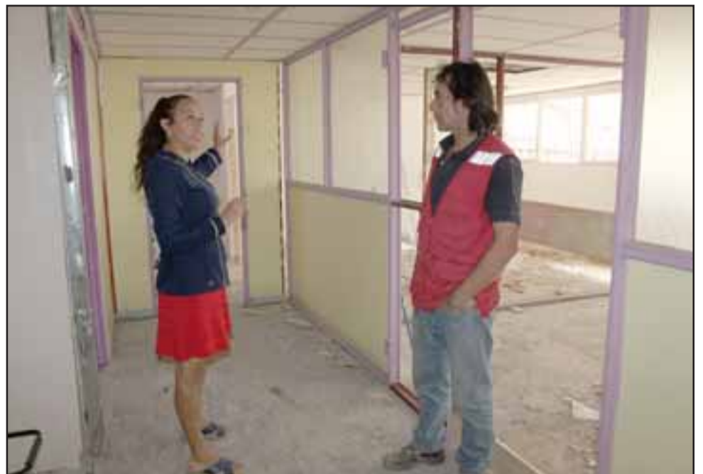
FALTA MUY POCO. - La directora Beatriz Gallardo supervisa personalmente los avances en cada etapa, aquí la vemos coordinando con los obreros los detalles de las nuevas aulas de la escuela.
