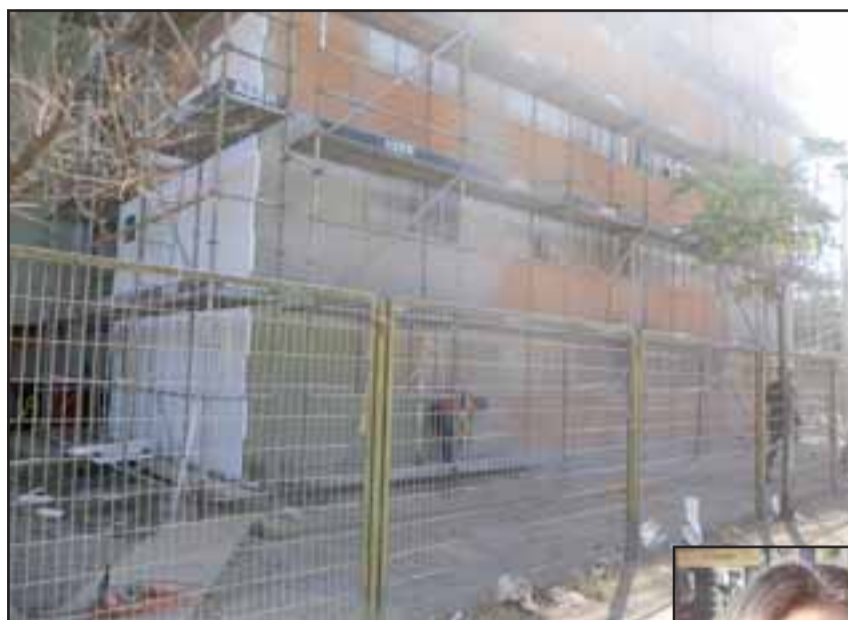
Acá vemos a personal trabajando en el mejoramiento de los departamentos.
