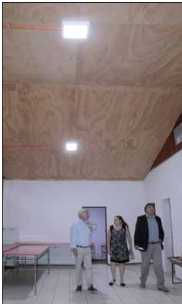
SEDE IMPEQUE. - Así luce ahora el cielo raso de la sede comunitaria, además, toda la instalación eléctrica se instaló nuevamente.
