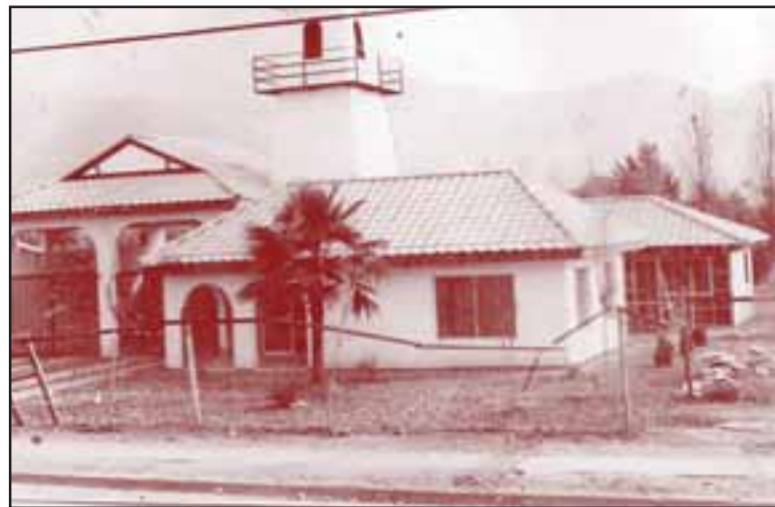
CUARTEL TERMINADO.- Así lucía este cuartel una vez terminado, una muestra fiel de que el trabajo en equipo, si se concentra en una meta definida, siempre será bien aprovechado.
