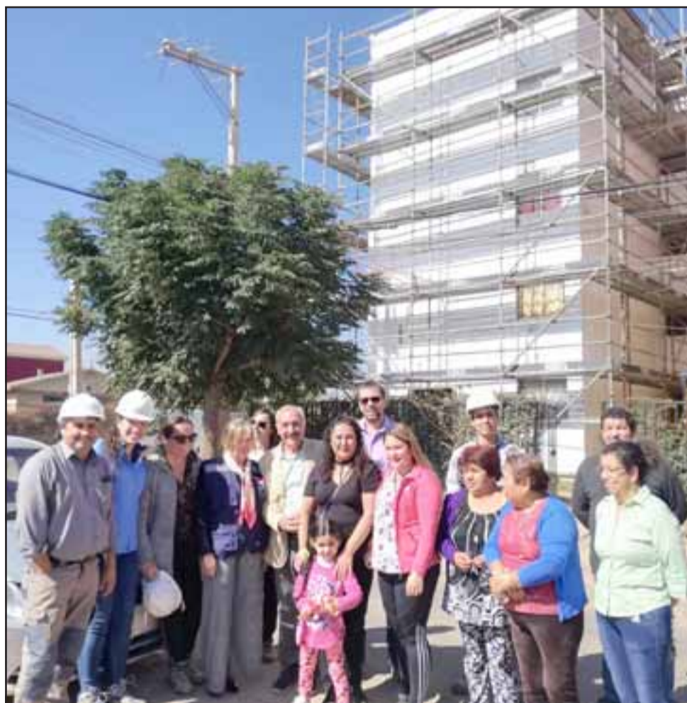
Autoridades municipales y del Serviu visitaron las obras y se reunieron con los vecinos para conocer los detalles de los trabajos efectuados a la fecha.
