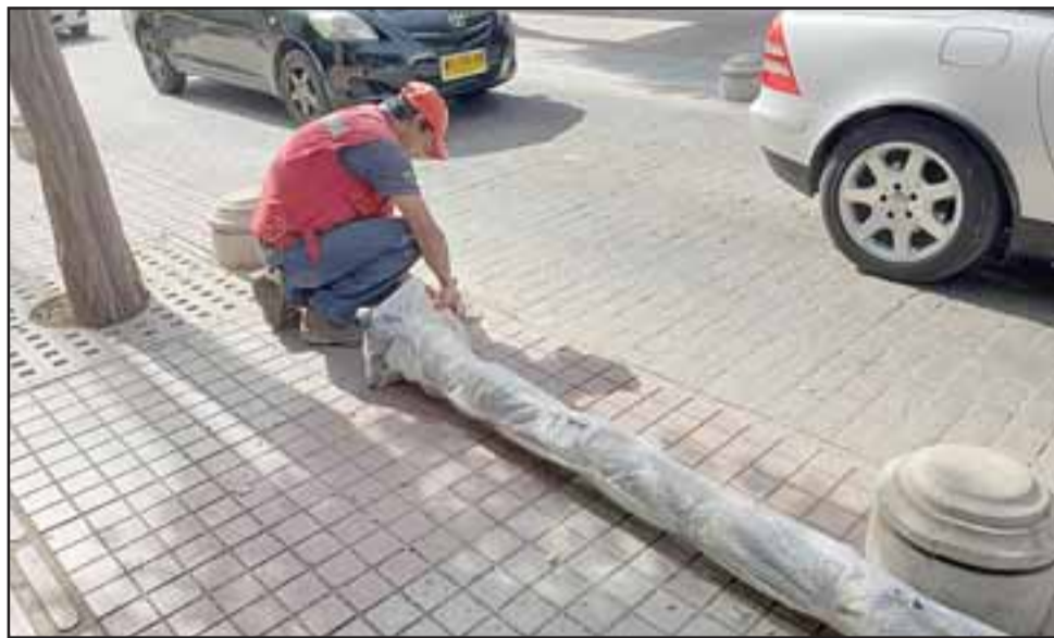
Las nuevas luminarias ya se han instalado en calle Prat y, durante estos días, se comenzó a instalar los de calle Salinas.
