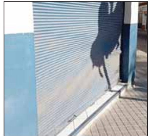
Solo daños menores en la cortina metálica dejó el fallido intento de entrar a robar al local de Librería Comercial de Santo Domingo esquina Coimas.
