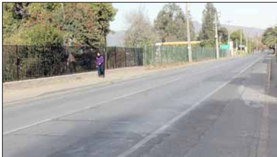
Un total de 15 familias serán beneficiadas con el proyecto que dotará de agua potable el sector ubicado entre el servicentro Shell y el kilómetro 12 de la ruta 601 o Troncal (ex ruta 60 CH).
