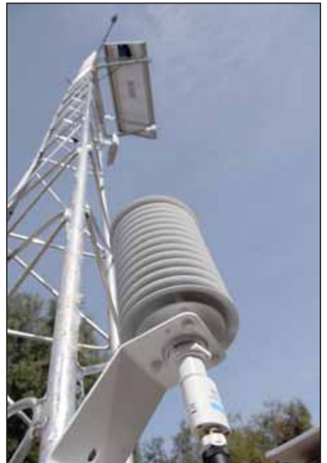
ANTENA PRINCIPAL.- Esta torre de 10 mts. es totalmente automática y autónoma, ya que funciona con un panel solar.
